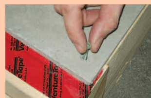
4 Trou plus grand que le diamètre de la vis
