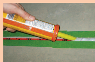
7 Pose du scellant adhésif flexible
