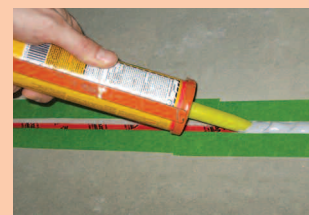
7 Pose du scellant adhésif flexible
