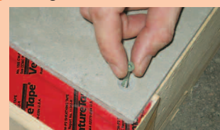
4 Trou plus grand que le diamètre de la vis
